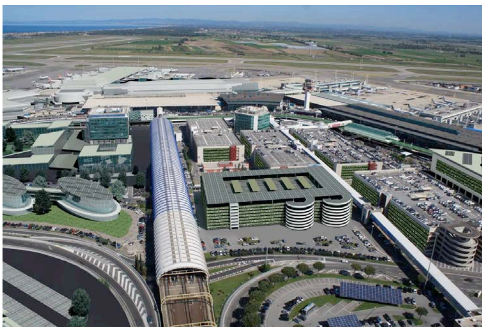
Progetto di completamento di Fiumicino Sud – infrastrutture area centrale
